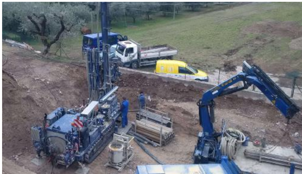
Calore dal sottosuolo La realizzazione di una sonda geotermica nel Comune di Cavaion
